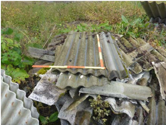
図 3 中岳第 1 火口南東約 12 km 地点での火山灰の堆積状況 (10 月 21 日 14 時撮影). 波板の窪みに火山灰が堆積している.
