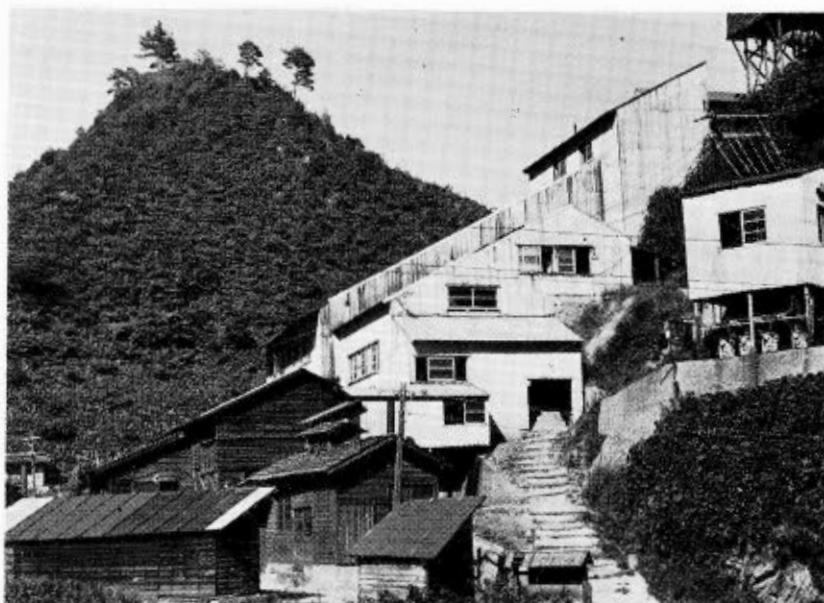
2. 丸山と改築後の清久鉱山選鉱場 1966年7月
