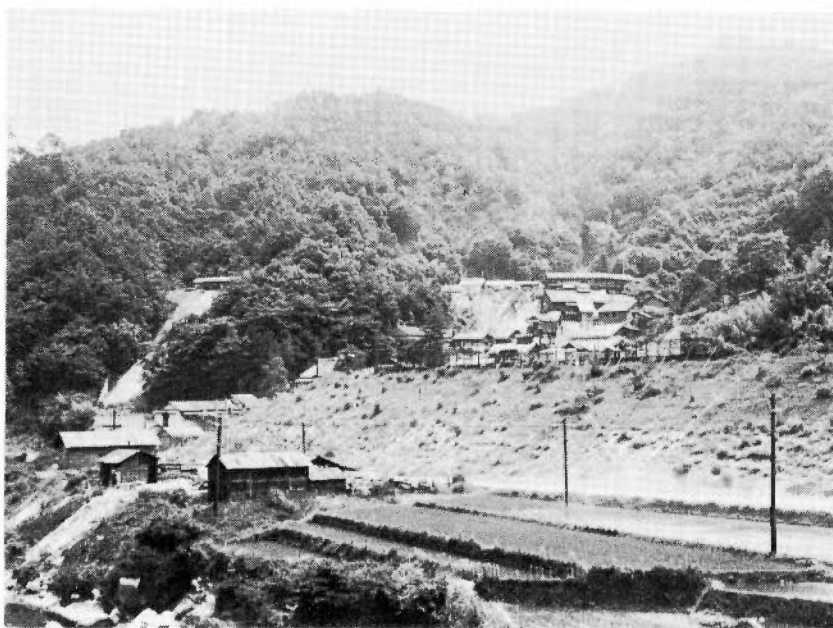
1. 大東鉱山全景 1965年6月 Mining facilities of the Daito mine (June, 1965).
