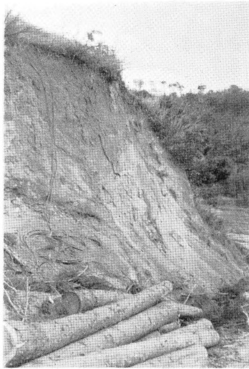
図版 14 玉島川ダム計画右岸の道路 この部分だけでも 5 m 位の厚さがある。そして全部「まさ」になっている。
