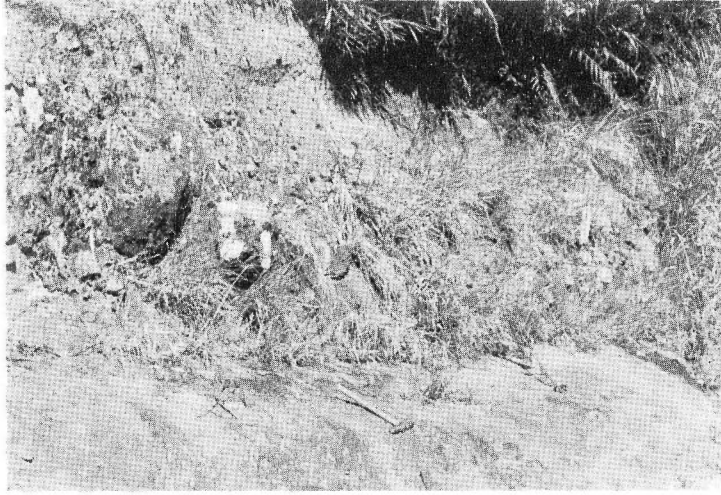
図版 9 川内川 山崎堰堤付近(右岸)の集塊岩 ハンマーの面で上下の集塊岩が捕獲している 礫の大きさが異なる。この面は水が通りやすい。
