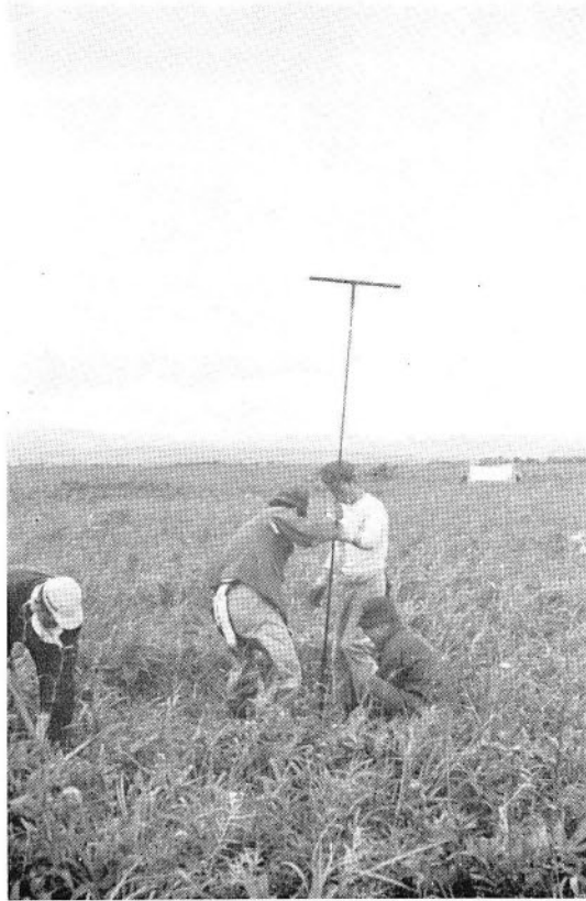
図版 5 さく孔。深度2.5m に達してビットを あげているところ。4人1組で作業している。
