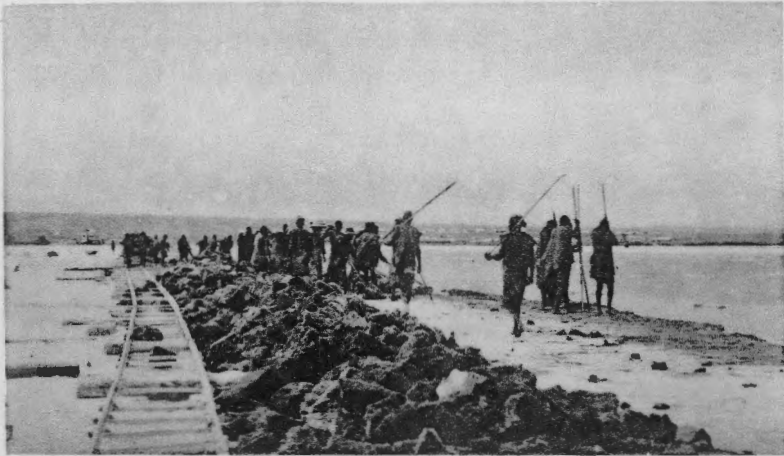
天然曹達探掘ノ狀況（鐵軌ノ左ハ堅氷ノ如ク堆積セル天然曹達、右ハ探掘跡ニシテ湖水(母液)ヲ湛フル部分）
