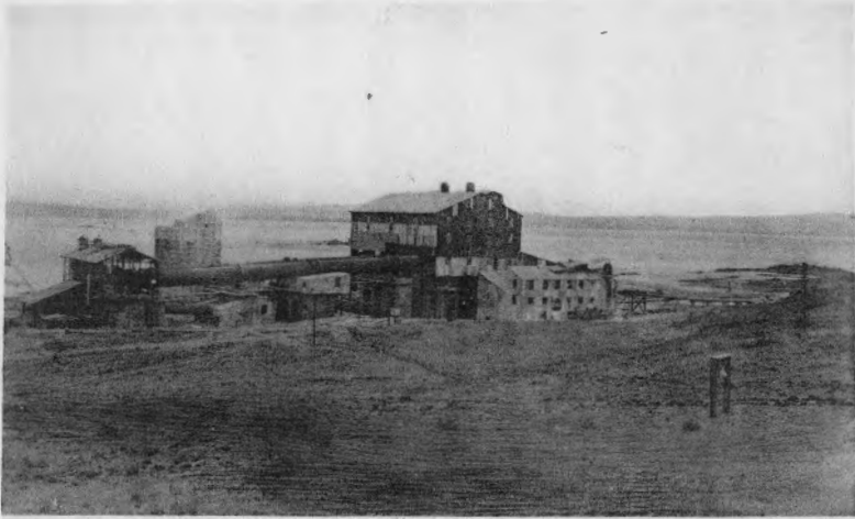
マガヤ湖曹達工場(洗滌及煨燒工場)
