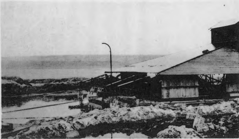
同上 (ホントー式探掘機 Excavator)
