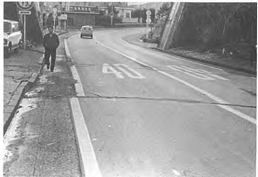
4. 断層運動のため右横ずれ変位した国道135号線稲取付近のセンター・ライン (Loc. 14) Right-lateral offset of the center line and side line of the route 135. (Loc. 14).
