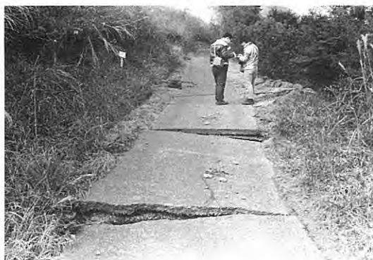
1. 断層運動によって右横ずれしたコンクリート路盤 (Loc. 50)
