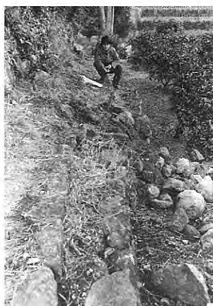
2. ミカン園内の石垣の右横ずれ変位 (Loc. 51). 断層通過地点の石垣は大破
