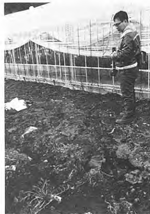
4. ビニールハウスと交差する雁行亀裂帯 (Loc. 37) En echelon fractures at Loc. 37.
