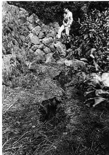
3. Plate 9-2 と同様、ミカン園内にあらわれた断層。石垣の破壊は断層の通過点だけに限られることに注意 Same as Plate 9-2
