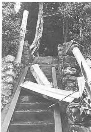
4. 地震のため破壊された愛宕神社の鳥居 (Loc. 23) Damaged torii of the shrine at Loc. 23.
