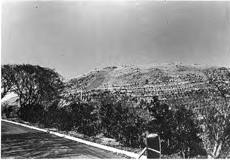
1. 浅間山南西斜面の遠望. 亀裂は画面の中央部を左から右に走っている Cracks on the southern slope of Mt. Sengen yama.
