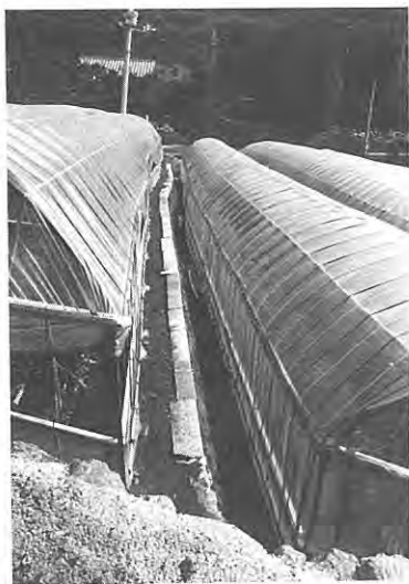
1. 断層運動のために変形したビニールハウスと石垣 (Loc. 40) Deformed greenhouse at Loc. 40.
