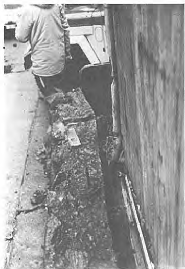
3. 断層運動で変形した石積みの塀 (Loc. 21) Deformed stone wall at Loc 21.
