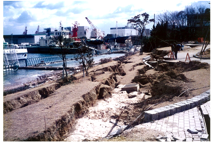
地震直後に見られるさまざまな地変。上は兵庫県南部地震における神戸港の地盤被害状況。下は噴砂現象。このような地質学的諸現象をすばやく正確に記録することが必要です。
