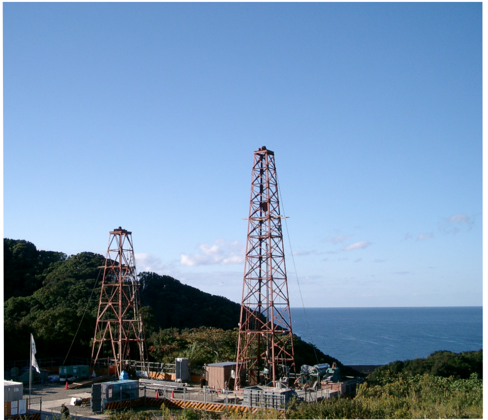
図1 整備がすすめられる地震地下水観測点。深さの異なる複数の観測井を掘削します。写真は近い将来発生が予想されている南海地震の想定震源域に近い高知県室戸市(図5の地点H)で整備が進められている観測点の様子です。
