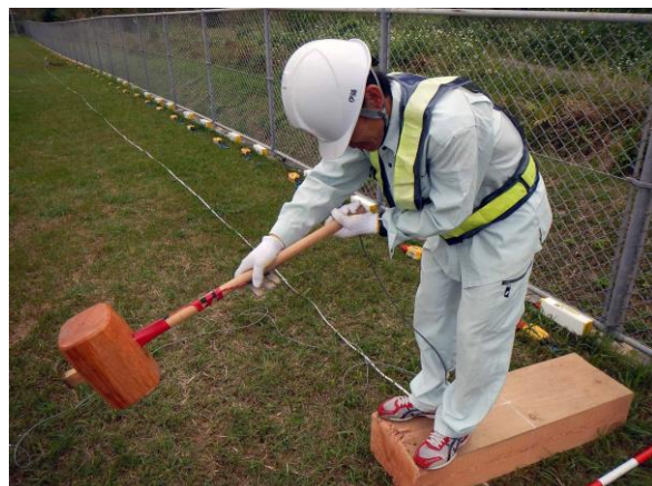
写真 2. 掛矢による板叩き発震の様子。
