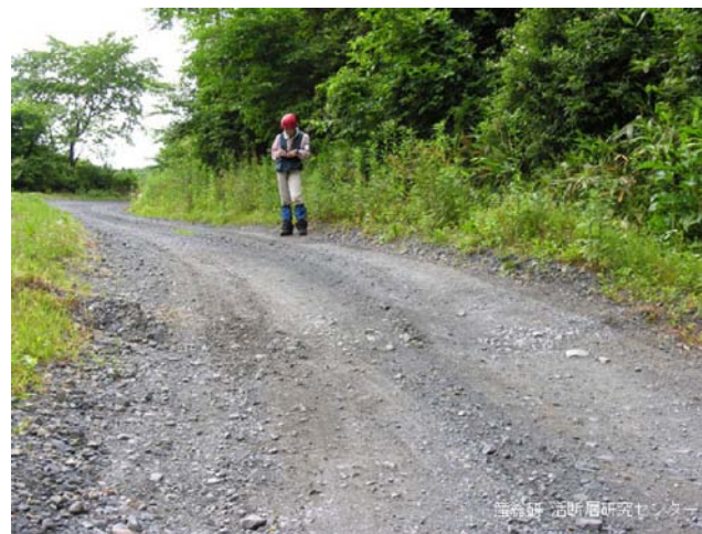
写真2 中川地区の砂利道を食い違わせている地震断層。西に向かって撮影。
