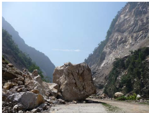
写真1 土砂滑りと落石で道路が寸断された。地震応急のため緊急に開通したが、巨大な岩塊は今でも道路の中央に残っている。
