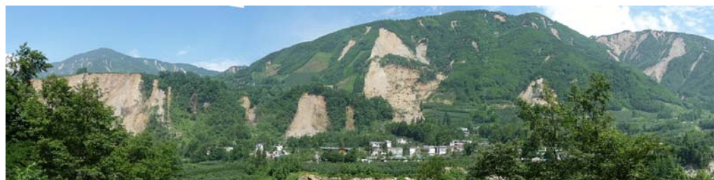
写真2 虹口渓谷沿い西側の斜面に多数の大規模な地滑りが発生した。虹口渓谷は漂流(カヌー下り)や避暑聖地として有名な観光地であり、深刻なダメージを受けた。さらに、斜面が不安定になり、雨が降ると土石流による2次災害が懸念されている。
