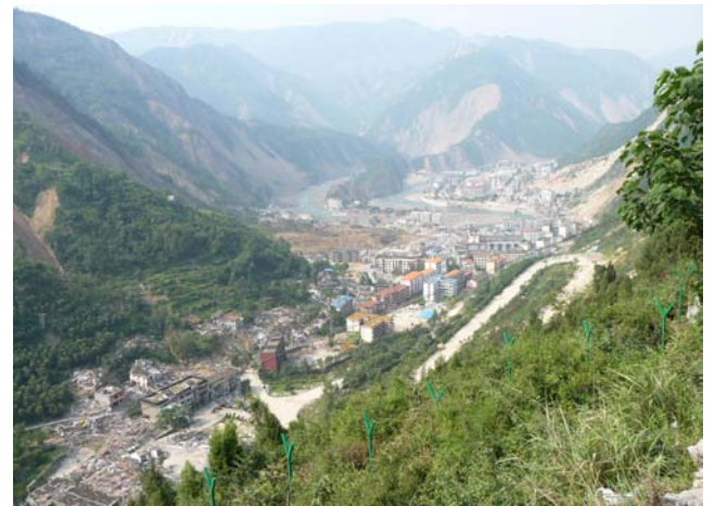
写真5 最も悲惨な被害を被った北川县城。
