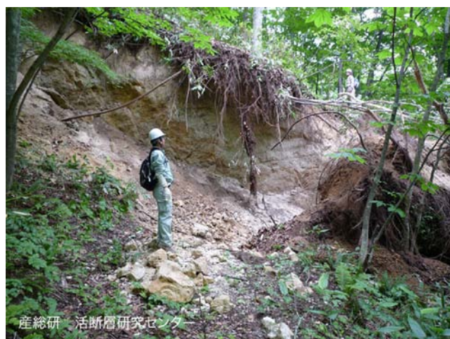
写真4 荒砥沢ダム北方の地震断層崖。北東に向かって撮影。
