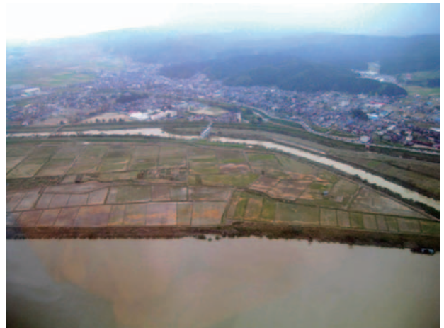
写真4. 地盤の液状化による噴砂現象(与板町市街地付近の信濃川河川敷, 10月25日撮影)
