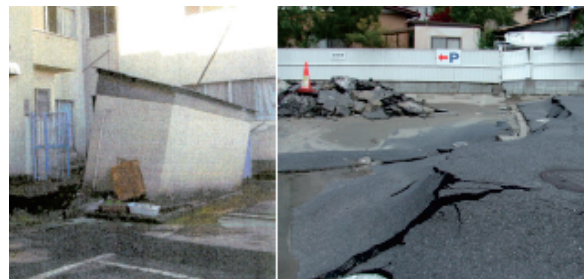
第2図 利根川下流地域における液状化被害の例 Fig.2 Examples of the liquefaction damage in the downstream Tone River area.
