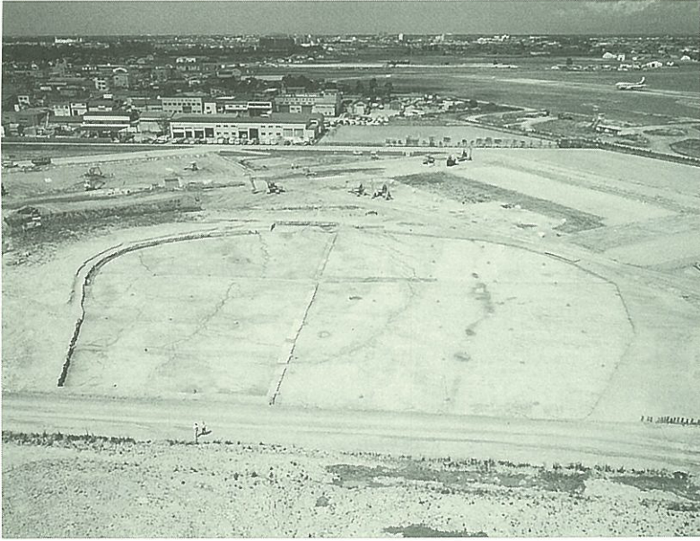
付図1 札幌飛行場（丘珠空港）北西隣の遺跡発掘現場に現れた液状化跡
