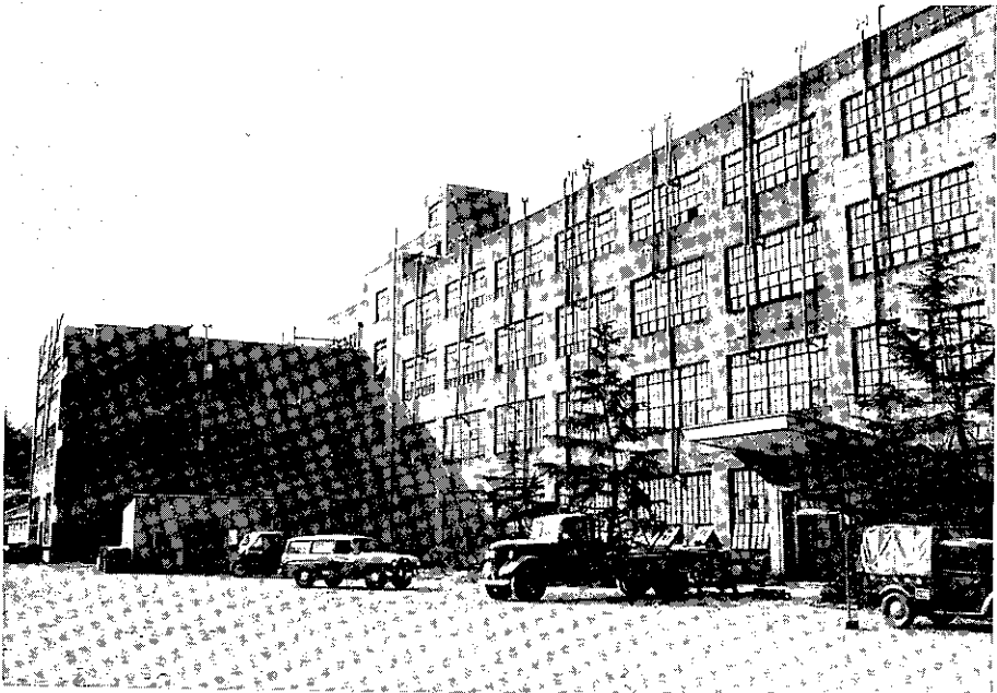
煙突の林立する溝の口庁舎
