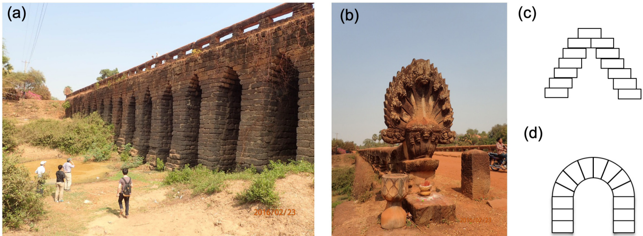
第7図 スピアン・コンボンクデイ遺跡 (a)。スピアンは現地語で橋を意味する。乾季のため河川の水はわずかである。現在も使用されているが、保護のために大型の車は通行していない。欄干にデザインされているナーガ(蛇神)は、アンコール遺跡群の至る所に見られ、水の神を守護する存在である (b)。スピアン・コンボンクデイ遺跡ほか、アンコール遺跡で見られる石積みは、擬似アーチ構造 (c) であって、アーチ構造 (d) とは異なっている。
