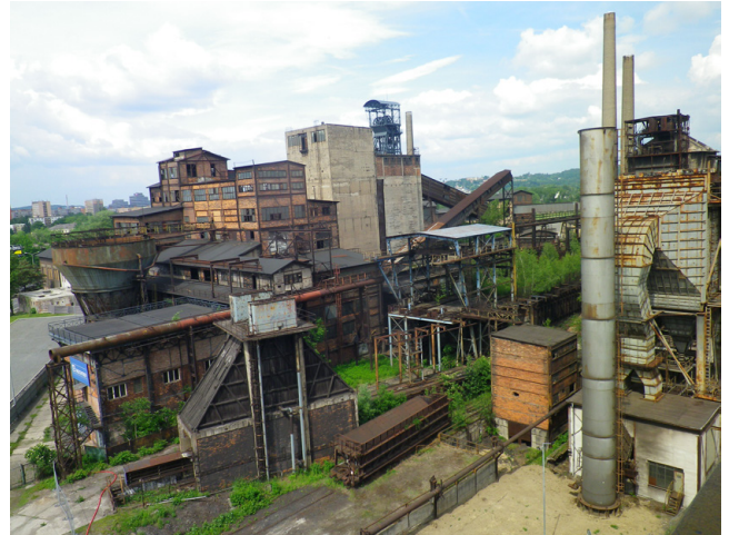
写真 2 オストラバの Vítkovice 地区にある製鉄所 (Dolní Vítkovice) 19 世紀に石炭開発により栄えた地域であり, それらの石炭を燃料として鉄の製造が盛んにおこなわれていた。工場を見学できるツアーがあり, 建物の上に登り, オストラバを一望できる。
