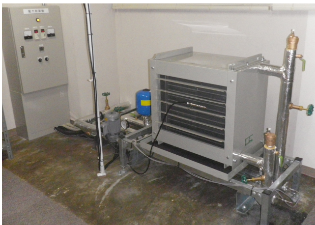
写真1 プレートフィンクーラー
