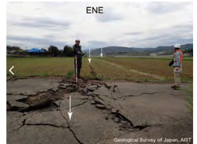
地震発生後の断層調査
