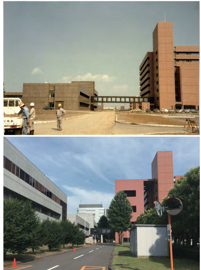
第2図 完成当時(上)および2018年現在(下)の第七事業所本館と海洋実験棟。手前に建物ができ、本館には耐震補強が增设された。その向こうには第一事業所の建物も見える。
