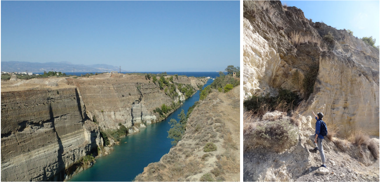
写真1 学会プレ巡検で訪れたコリントス運河（左）と側道の断層露頭（右）。
