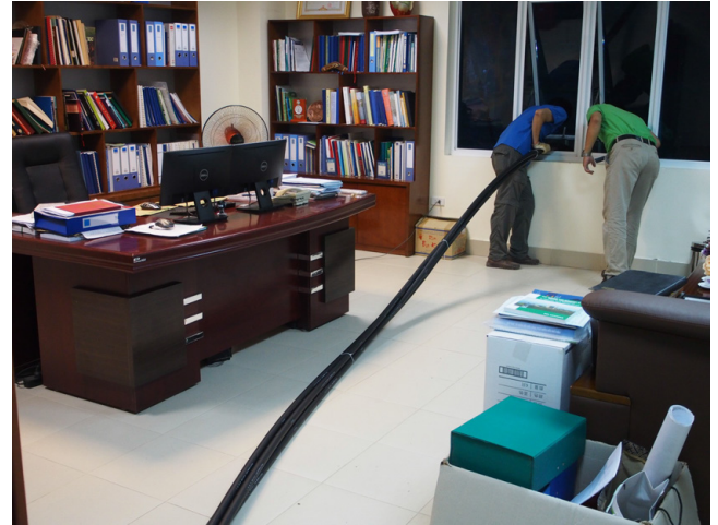
写真4 2階の所長室より熱交換パイプを掘削孔へ挿入。
