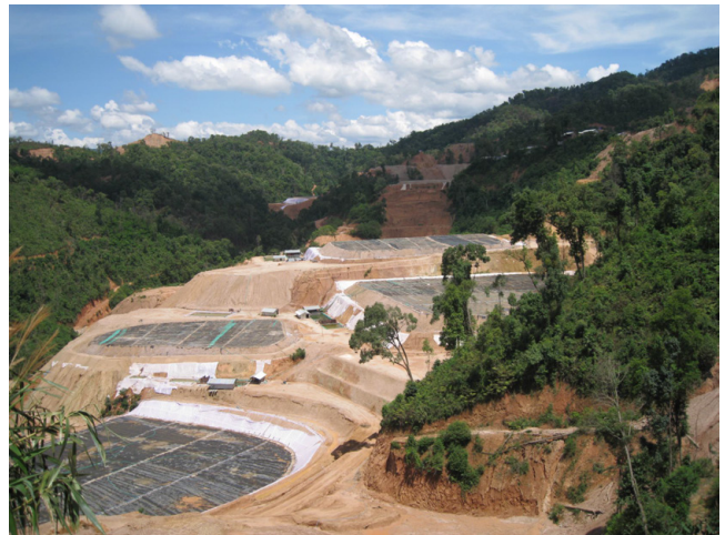
写真2 金鉱山の現場での浸出液を使った選鉱の様子。 位置は第2図の星印2。2016年6月16日撮影。
