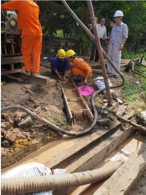
写真3 デッチ(写真中央)を用いて泥水の濃度を調整。
