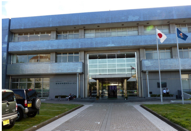
第1図 会場の静岡県地震防災センター。
