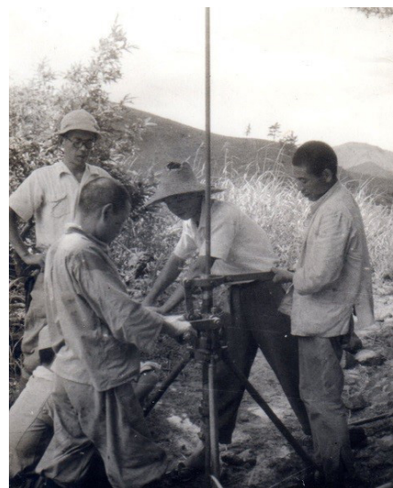
第3図 表層(深度3～6m)の地中温度測定。
