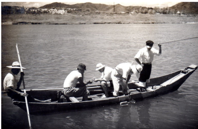
第5図 河川流量測定作業状況。 (河川水がどの程度地下水となるかを知るため川の流量を2か所の断面で測定してその差を求めて算出する)
