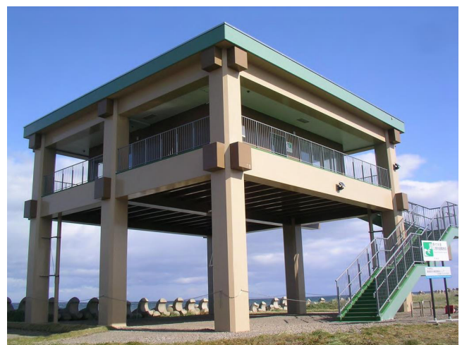
第11図 2016年春に完成した野付半島ネイチャーセンター眼前の野付半島災害時避難施設。
