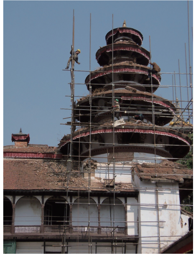
第13-4図 命綱なしの復旧工事(ボダナート)。
