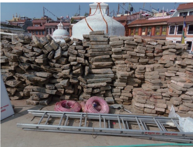
第13-3図 崩壊した仏塔の建築材。煉瓦の他に、左に積み重ねられた結晶片岩を整形加工した平石が大量に用いられていたことは新たな知見である。
