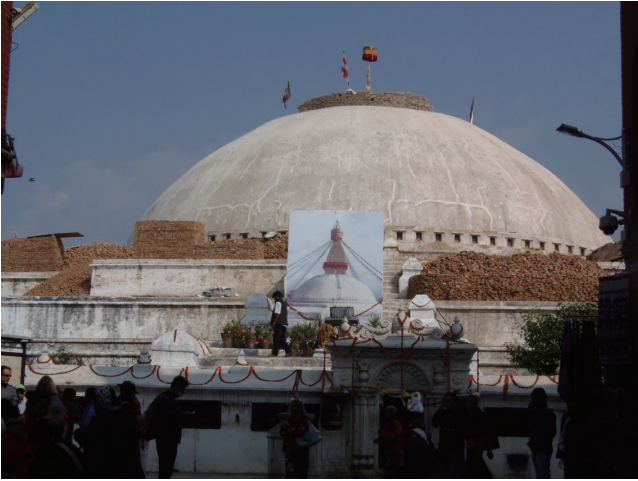
第13-1図 カトマンズ市街の約9 km 東に位置するボダナート Boudhanath の15 世紀に再建されたネパール最大のストゥーパ(中央の写真は地震前の状況)は、地震で損傷を受け7月時点では周囲にやぐらを組んで保護していたが、11月には地面に降ろし修復作業をしていた。
