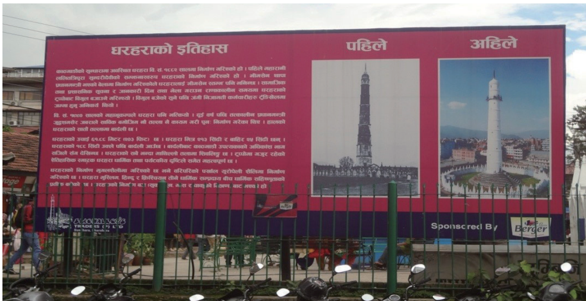
第12図 ダラハラ塔(左の写真はビハール・ネパール地震前、右の写真はビハール・ネパール地震後に再建された塔の様子)。
