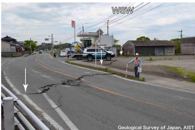
写真11 飯野小学校南の国道443号線に見られる縦ずれ変位。写真は西南西方向に向かって撮影。上下変位量は約15 cm。(2016年4月16日撮影)
