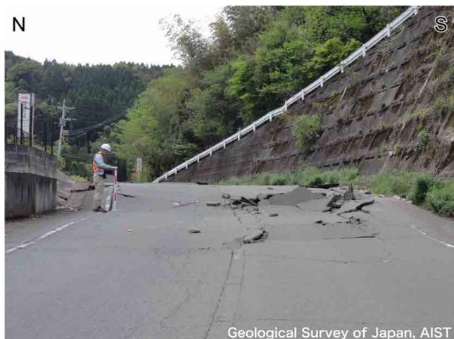
写真3 上陳集落の舗装道路に見られる短縮変形。写真は南東方向に向かって撮影。上下変位量は約40 cm。断層はN70E方向に続く。(2016年4月16日撮影)
