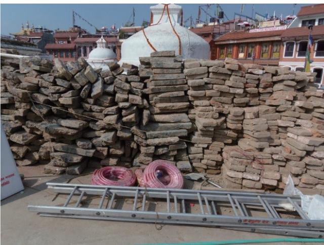
第13-3図 崩壊した仏塔の建築材。煉瓦の他に、左に積み重ねられた結晶片岩を整形加工した平石が大量に用いられていたことは新たな知見である。
