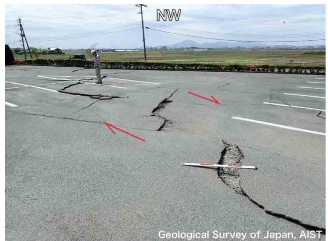
写真8 赤井集落「益城町町民いこいの家」駐車場に見られる右横ずれ変位。写真は北西方向に向かって撮影。右横ずれ変位量は約40～50 cm。(2016年4月16日撮影)
