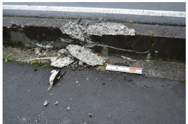
写真3 本震の震央付近(地点2:恩鳥)で観察された縁石の破壊。左横ずれを伴わず、周辺への延長も認められないため、地表地震断層を示すものではないと判断した。
