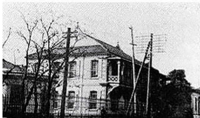
第1図 地質調査所木挽町旧庁舎（関東大震災前）。
