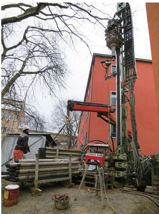
写真4 共同住宅におけるBHEの掘削現場。周辺は住宅が密集している地域であるが小型の掘削機によって掘削が行われている。
