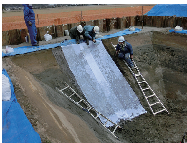
トレンチ壁面に布を張り、樹脂を塗り込んでいる様子.
