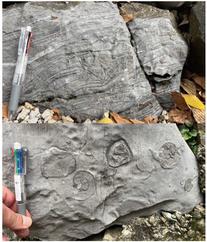
第3図 石垣の石灰岩にみられるフズリナ化石(左)と大型の二枚貝化石(右上), 巻貝化石(右下). (左) Parafusulina 属と思われる大型の紡錘形のフズリナ. 中期ペルム紀を示す. (右) 大型の二枚貝や巻貝の化石もみられる. これらは付近の金生山(赤坂石灰岩)から産出することが知られている. いずれも明治期以降に金生山から「美濃霞」「美濃黒」「黒縞」などの銘柄で流通した大理石石材と同様の岩相である.
