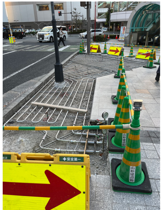
第 4 図 山形駅前の無散水融雪パイプ交換工事の様子 (GSJ 斎藤 眞氏提供)。
