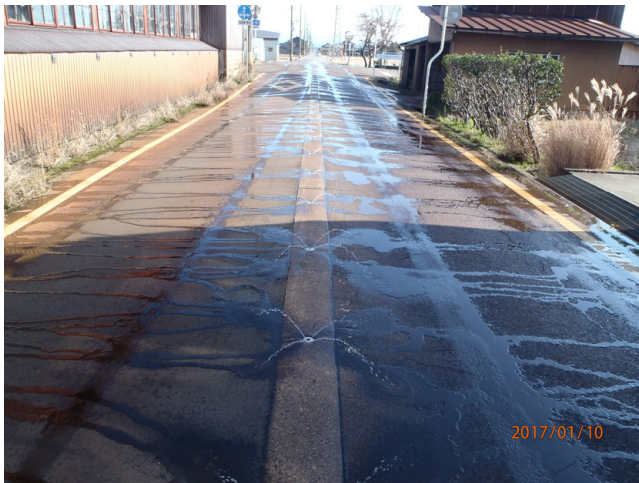
写真 1 消雪パイプから水が流出しているところ。
