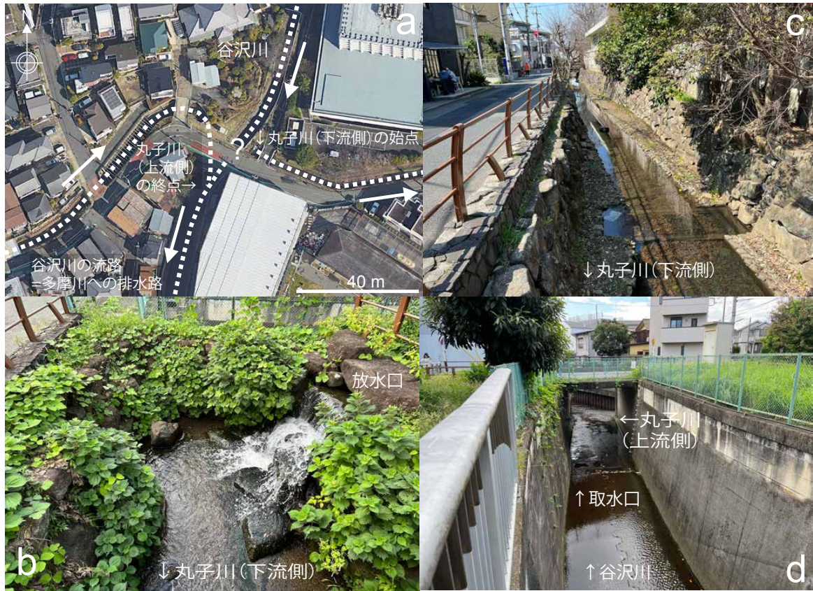
第3図 無名1号橋付近の河川の状態。(a) 丸子川と谷沢川が十字にクロスする無名1号橋付近の画像。基図として、Google Earthの画像を使用した。(b) 丸子川(下流側)の放水地点。ポンプで汲み上げられている。白の点線と矢印で、各河川の流れを示す。(c) 丸子川(下流側)の状況。(d) 丸子川(下流側)と谷沢川の合流地点と取水口の位置。
