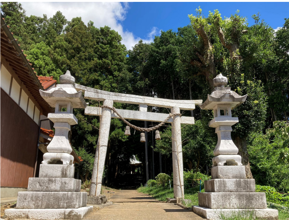
第1図 菅原神社の表参道にある鳥居と石灯籠. それぞれ明和5(1768)年, 嘉永3(1850)年の奉献. 全て粗粒の方解石結晶からなる結晶質石灰岩が使用されている. 現在確認できる秋吉台大理石石材の銘柄としては「霰」や「伊佐白」に類似する. 平成30年に鳥居の一部が崩落したため, 新たに貫(横方向の下段)の部分に長さ3.2mに及ぶ大理石石材「霰」を調達し, 再建と塩酸による表面洗浄が行われた. 野外にある大理石石造物は風雨に晒され黒ずんでいくことが多いが, 洗浄により石材本来の神々しい白さを取り戻している.
