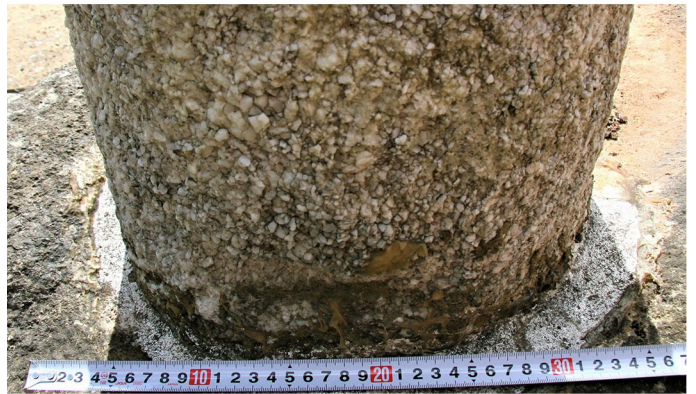
第6図 貫の表面仕上げ(上)と柱の方解石結晶(下)。新造の貫表面には、元来の石材に倣い「ノミ切り仕上げ」が施されている。一方で奉獻当初からの柱の表面にはノミ跡とは別に風化により凹凸が生じている。粒径2~4 mm程度、大きいもので10 mm程度の方解石結晶が観察される。
