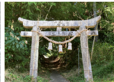
第4図 裏参道の鳥居. 文政4(1821)年の奉献. 表面は全体に黒くすすんでいる.
