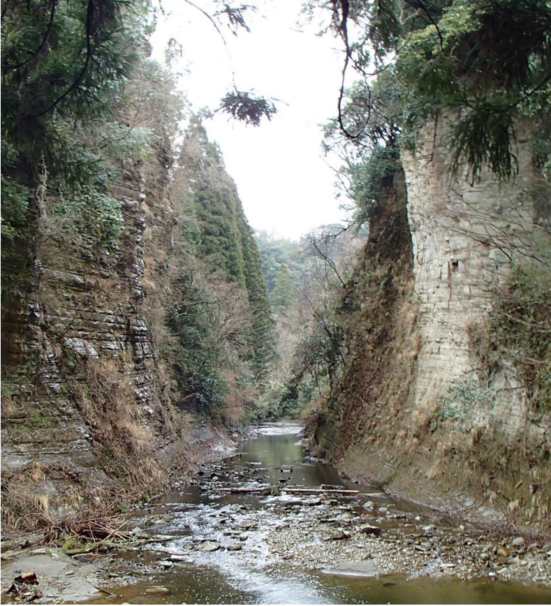
第7図 養老川本流(手前)に川廻しの目的で人工的につながれた弘文洞跡 ジオクイズ：両側の崖に露出するのは、大田代層上部の泥岩優勢互層ですが、いつも左手の崖の表面は濡れており、一方、右手の崖の表面が乾いています。それはなぜでしょうか(詳細は本文参照)。
