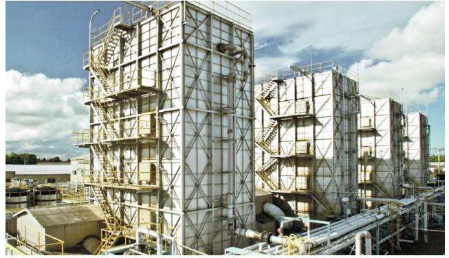
第28図 第16図の放散塔と吸収塔が入った巨大なブローアウトプラント群 (株) 合同資源のパフレットより引用。
