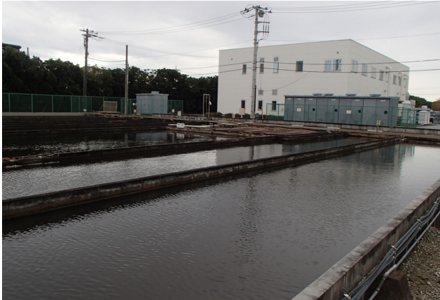
第25図 かん水の集水池 各地から集められたかん水中の懸濁物をここで最終的に沈積させ、ヨウ素の濃集工程に送ります。
