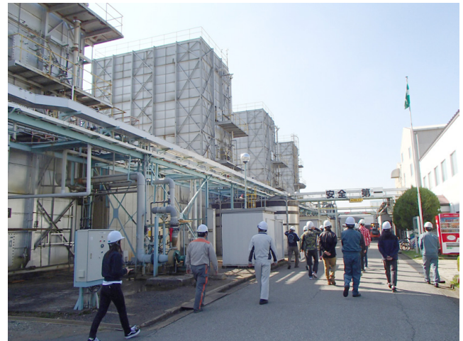
第29図 巨大なブローアウトプラント群の横を歩いている様子
