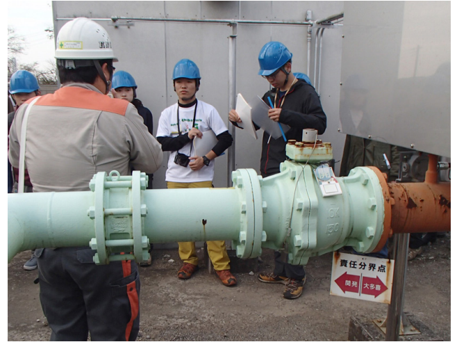
第13図 パイプの塗装色で示された天然ガスの管理責任境界
