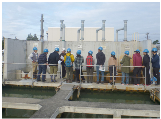
第10図 セパレーター正面の沈砂槽の上での説明風景
