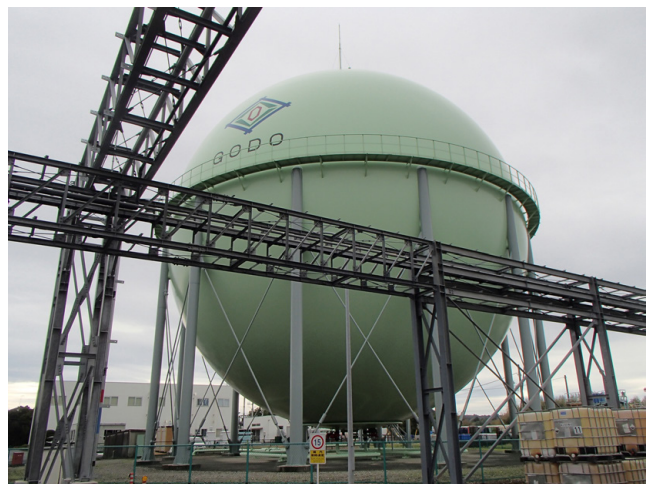
第27図 (株) 合同資源のマークの入った巨大なガスホルダー 生産した天然ガスを需要先に送るための一時的貯蔵タンクです。
