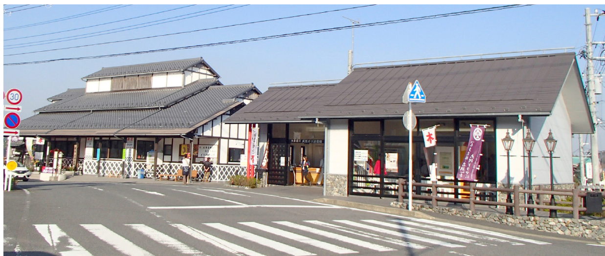
第3図 大多喜町天然ガス記念館(右側) 左手の建物は、大多喜町観光本陣。手前の横断歩道の左手に、いすみ鉄道大多喜駅があります。
