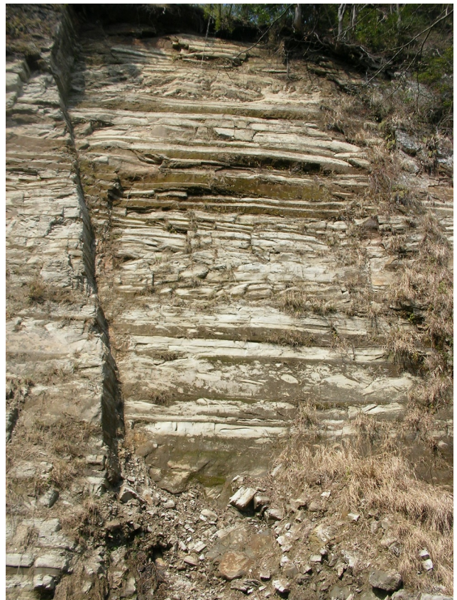
第20図 養老川沿いの崩落崖に露出する黄和田層 白色部は泥岩で暗褐色部はタービダイト砂岩。崖の上部には横臥褶曲状に、あるいは折りたたまれるように変形した泥岩層がタービダイト砂岩層中に含まれている様子が、中部には大小の泥岩ブロックが密集している様子が、また下部には、大小の泥岩破片がタービダイト砂岩中に浮かぶように散在している様子がうかがえます。崖の高さは約20m前後。なお、左側にみられる垂直に近い直線は、断層(面)ではなく節理(面)です。養老川沿いに伸びる栗又の滝遊歩道から撮影。大多喜町栗又。
