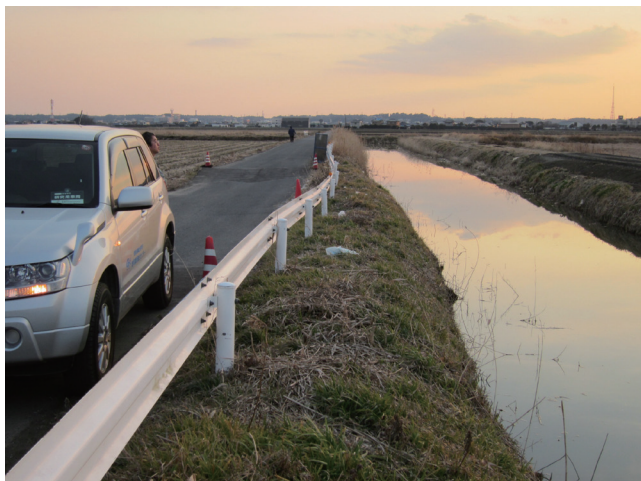
第2図 千葉県香取市において液状化によって水路側に張り出した道路（左）と、沈下した水田（右）。
