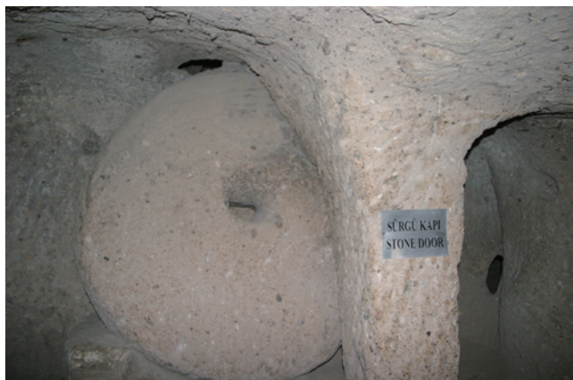
第16図 カイマクル地下都市の石の回転ドア。 外敵が侵入してきたときには、この石を回転させて通路をふさぎ防御するのだそうです。現場の石材をそのまま繰り抜き、細工して使用しています。
