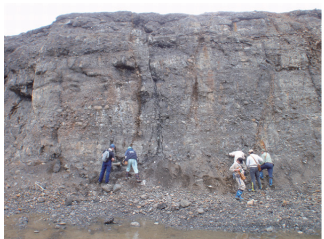
第3図 地点① オビラシケ川沿いの採石場(東工業(株))で見られる, 河川(扇状地)堆積物の特徴を持つ別保層の礫岩層。
