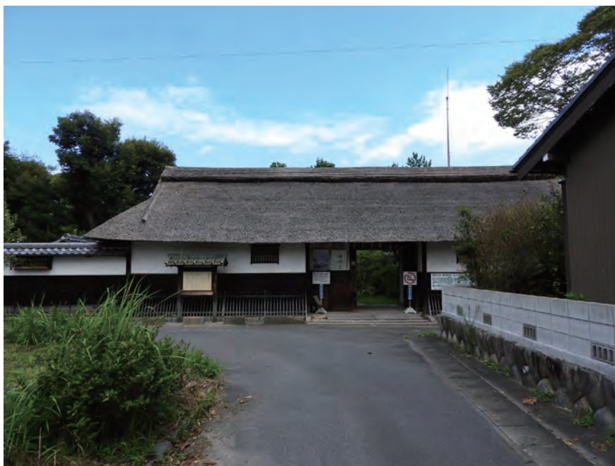
第2図 弥富市荷之上の重要文化財・服部家住宅。 Fig. 2 Important cultural asset Hattori-ke house in Ninoue, Yatomi City.
