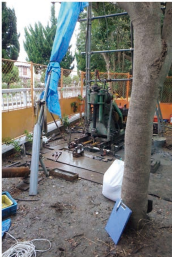
第4図 ボーリング調査地。 ボーリング地点は擁壁の脇2mの位置である。
