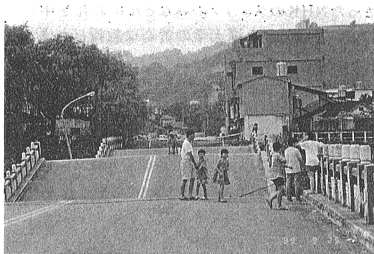
写真6 大甲溪にかかる長庚橋の破壊 (太田撮影).
