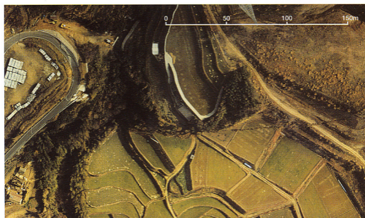
写真79-2 同地区における直線状野島地震断層の拡大航空写真[アジア航測(株)撮影(1995.1.17)].
