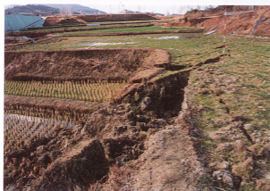
写真84-2 同谷底西岸側における棚田段差の破断・崩壊(第50図A地点を南西方向に見る)[水野清秀氏撮影(1995.1.27)].
