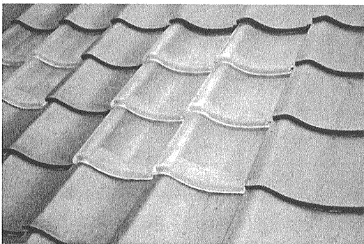
写真8 ガラス製の棧瓦。4～6枚が1セットとして使われ、明かり取りの天窓となる。遠目には天窓があるようには見えない。
