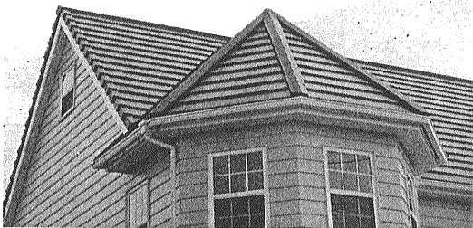
写真7 平板瓦の例。全くの平板型であり、凹凸がほとんどない。最近、洋風の住宅に広く用いられている。
