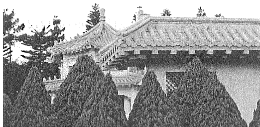
写真14 台湾製の瓦とその使用例。(上)丸瓦(あるいは筒瓦)と軒瓦の一種である滴水瓦がみられる。台湾中部の豊原市で撮影。(下)平瓦と丸瓦を使った本瓦葺き。高速道路1号線のサービスエリアの付置公園の建物の例。
