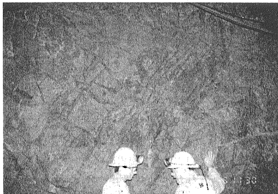
写真4 角礫化が最も弱い母岩。割目化花崗岩。サービス斜坑-350mL。
