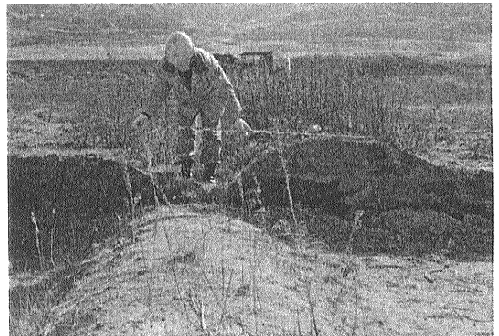
写真50-9 地震断層に直断された農道の変位(第15図C7地点)。写真50-8の中央部分。南東側(上盤)が水平成分(西南西)へ約120cm、鉛直成分約50cmで、長さ約130cm分だけ南西方向にせり上がった[川崎満男氏撮影(1995.1.18)].
