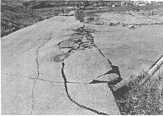
写真49-3 農道T字路におけるアスファルト路面のひび割れ(第15図B3地点)[水野清秀氏撮影(1995.1.27)].
