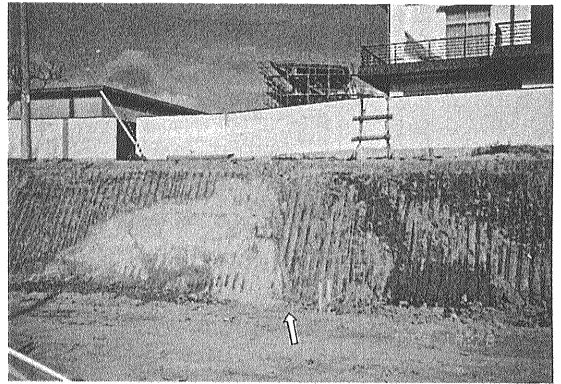
写真55-2 同氏邸南西隣の新しい切り土側壁に露出した地層境界断層(矢印). (第17図の位置B)[河野道信氏撮影(1998.1.27)].
