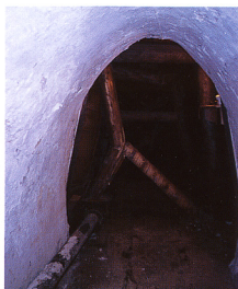
4. 岩塩のクリープ性流動のため坑内の柱は至る所折れ曲がっている。
