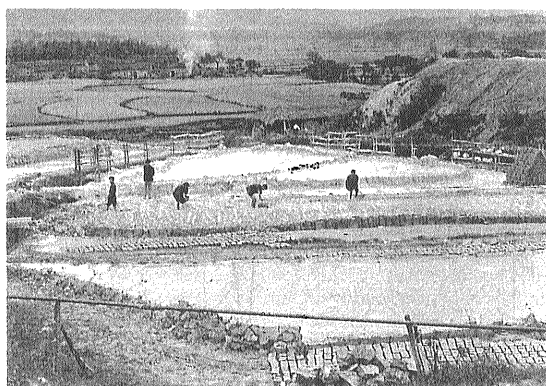
写真3 丘の麓につくられた水簸場。水簸物は乾燥しながら、煉瓦状に切りそろえられる。
